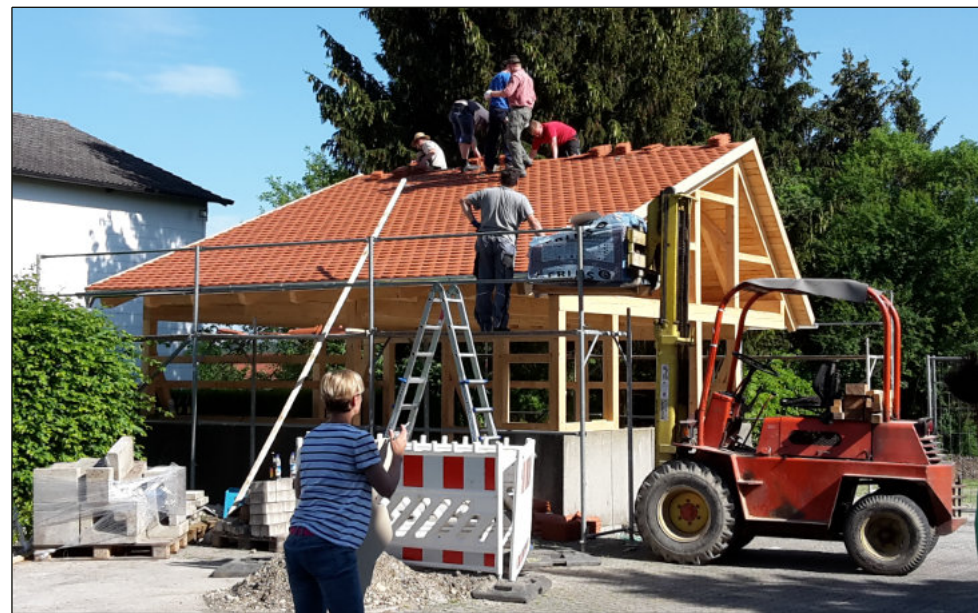
Voller Einsatz beim Bau der Lagerhütte
