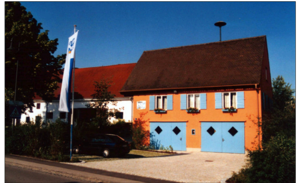
Das zweite Feuerwehrgerätehaus im Erdgeschoss des Rathauses an der Ammerseestraße (heute Bücherei bzw. Bauhof) Foto: Gemeindearchiv
